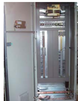
图3-3: 快速切换装置SUE3000的安装
